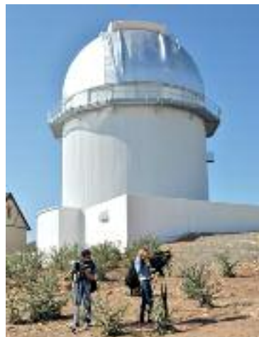
Instalaciones en Javalambre.
